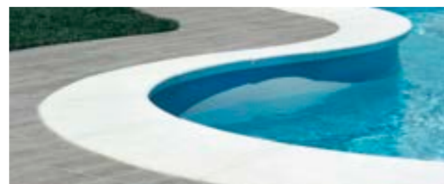
Esempio di posa del bordo vasca allo stesso livello del pavimento.
